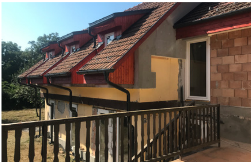
BUDYNEK POLONIJNEGO CENTRUM EDUKACYJNEGO PRZY ULICY TULIPÁN 25 W TRAKCIE REMONTU
