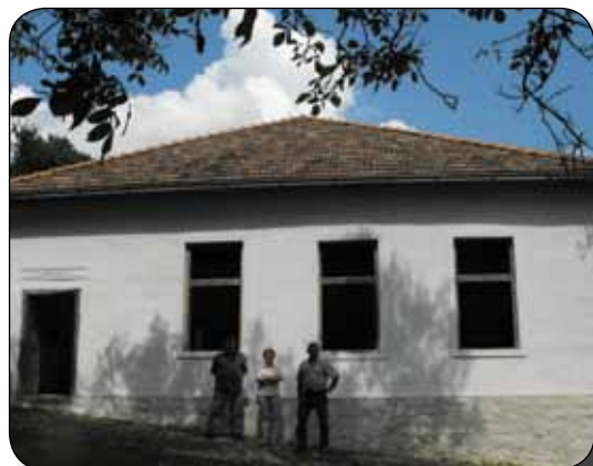
Az iskola felújítás eredménye
